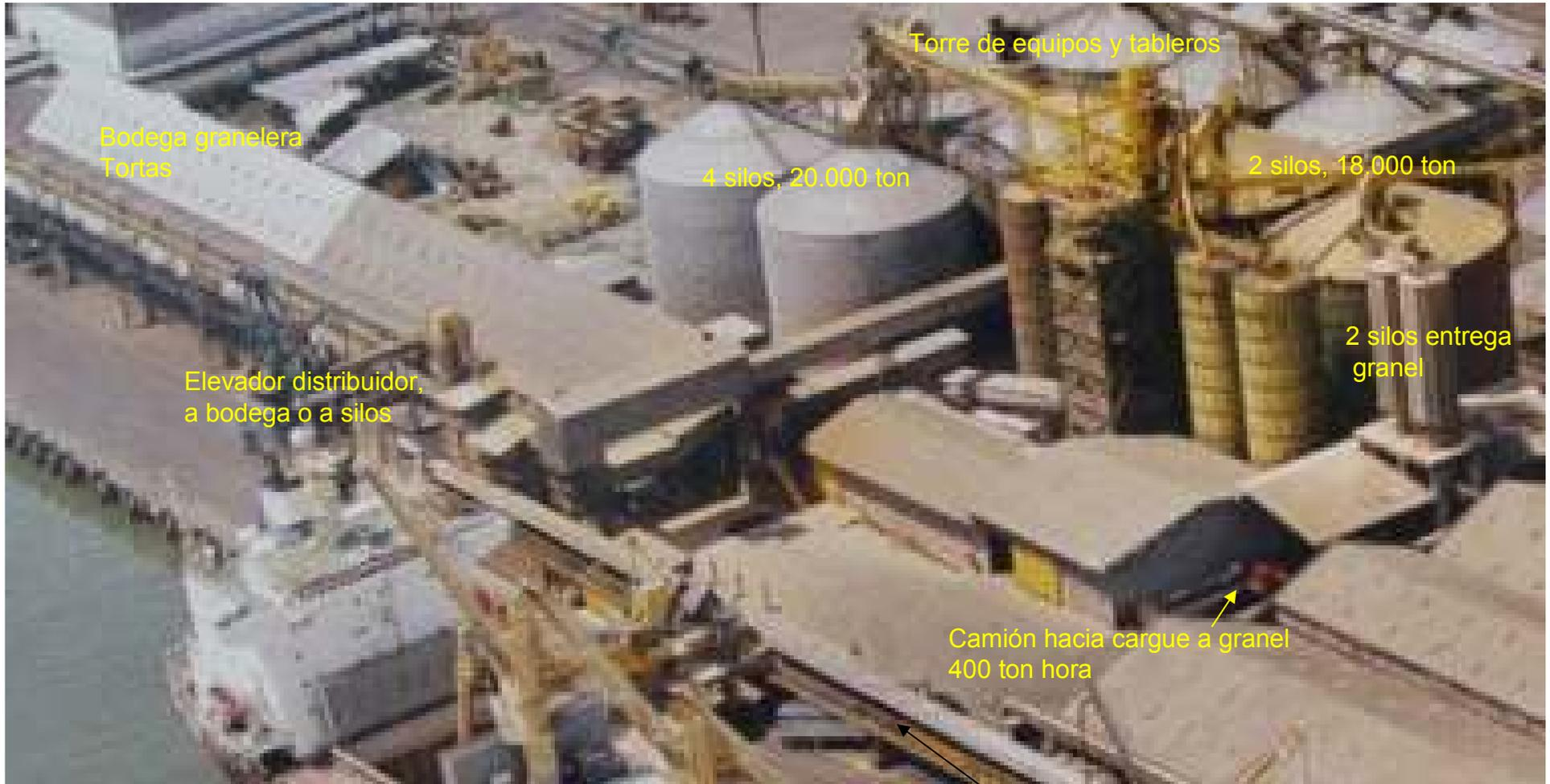
Transportador recibo de máquina descargadora, 600 ton/hora
